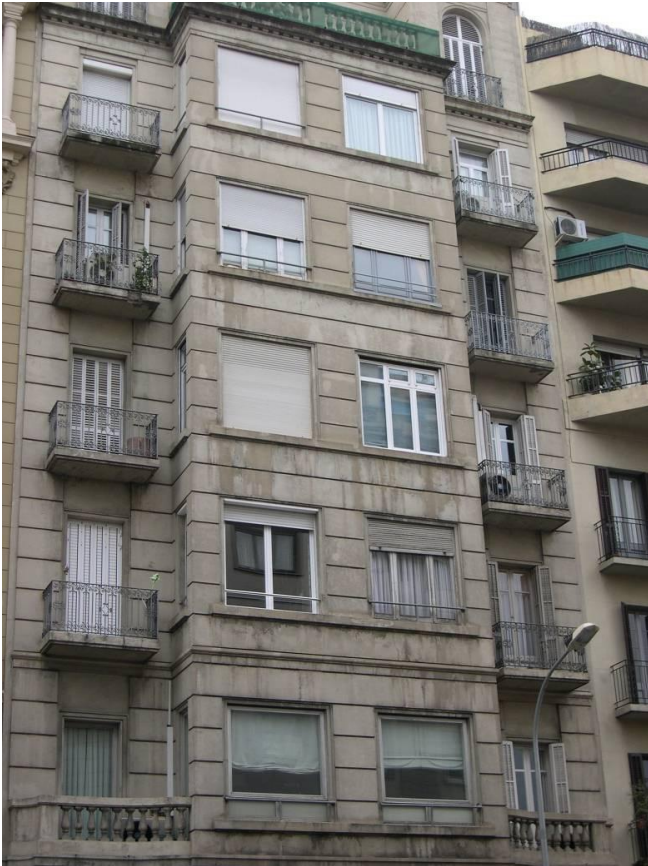
Autarquía en la rehabilitación acústica de ventanas y balconeras
