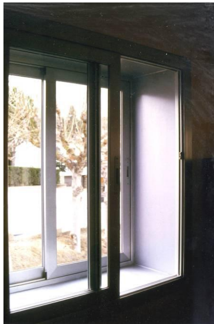
Doble ventana (independiente) con cámara de aire, en el Centro Cívico de Navarcles.
