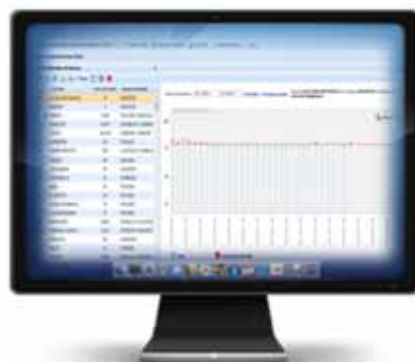
Centro de control
